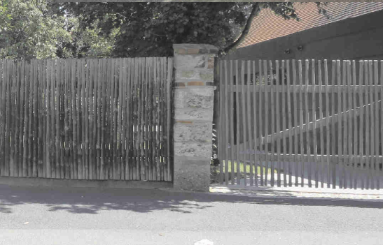
Der Zaun im Zustand vorher (rechts) und nach der Austauschmaßnahme.
